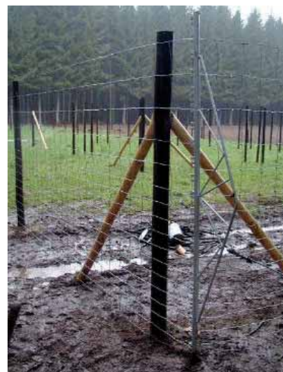
pose et tension du treillis
