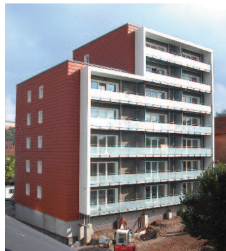
Inauguré début 2014, ce bâtiment en bois de 26 appartements, que nous visiterons, est le plus haut de France.
