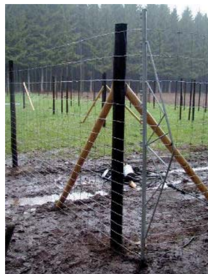
pose et tension du treillis
